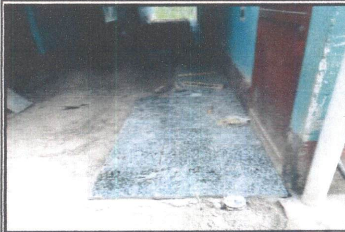
Foto 2: La colocación de piso granito en pasillo del centro educativo.
