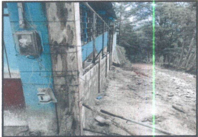
Foto 1: reparación de muro con maya galvanizada.
